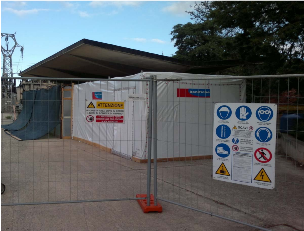
Figura 7.2-2: Esempio di area confinata cantiere rimozione amianto
