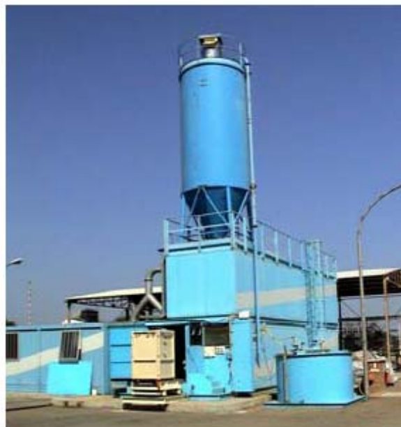
Figura 8.4-1: Impianto ICAM per la stabilizzazione di amianto in matrice cementizia
